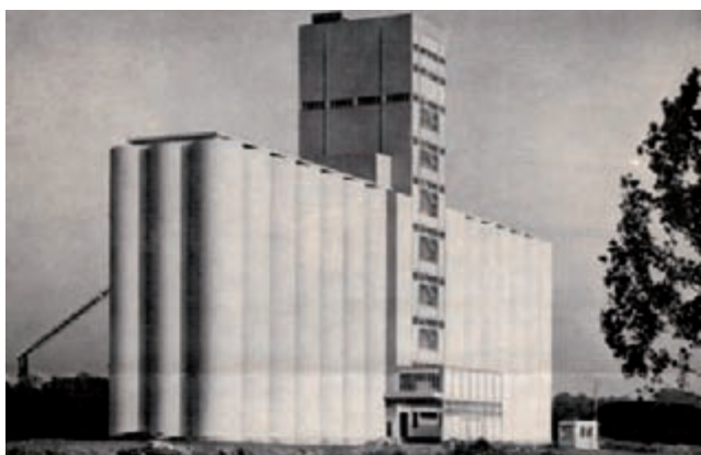
Après le silo de Gennevilliers (1957), l'UGCAF construit au début des années 1960 le silo de Givet (ci-dessus) dans les Ardennes puis celui d'Arleux, près de Douai, en 1965.
