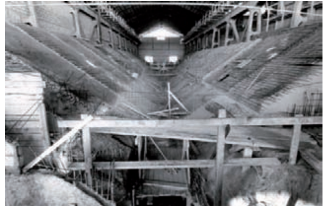
Les premiers grands travaux de modernisation et d'agrandissement du silo de La Grande Paroisse, le 29 avril 1956.
