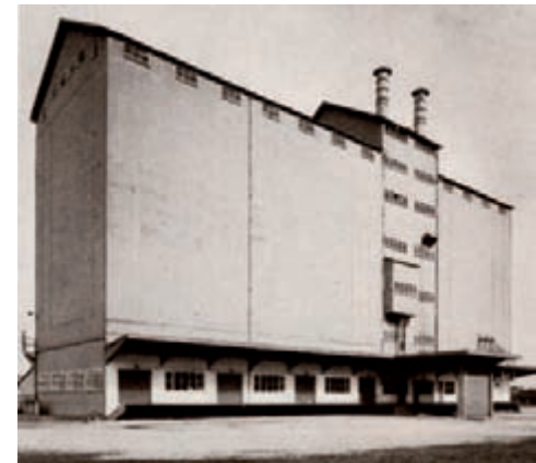
Le silo de Mantes en Seine-et-Oise (Yvelines aujourd'hui) d'une capacité de 100 000 quintaux.
