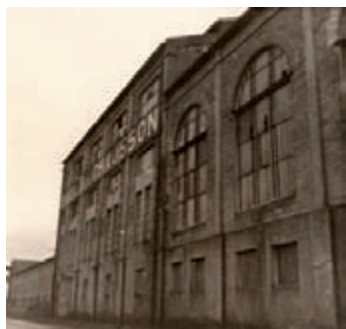
La cimenterie désaffectée Poliet et Chausson en 1954 à La Grande Paroisse (77), avant son achat par l'UNCAC.
